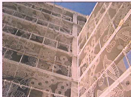
4 - Parement de la façade d'un immeuble par Lace Fence
